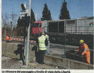
La chiusura del passaggio a livello di via della Libertà
